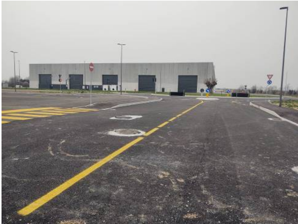
Figura 5.12. Rilievo fotografico dello stato attuale dei luoghi – Punto di ripresa n. 3 verso nord
