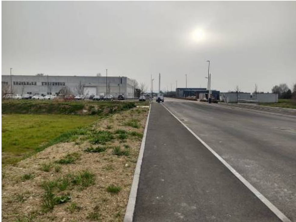
Figura 5.10. Rilievo fotografico dello stato attuale dei luoghi – Punto di ripresa n. 1 lungo Via dell’Innovazione
